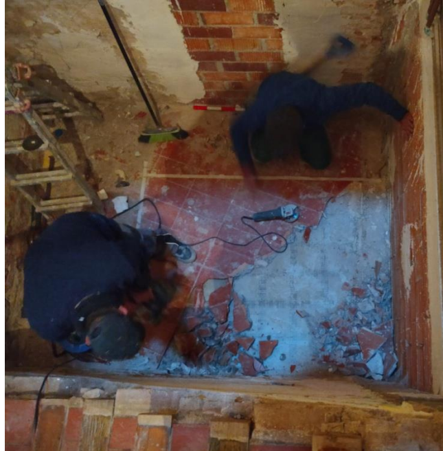
Foto 3: Fotografia de treball inici extracció paviment de rajoles.
